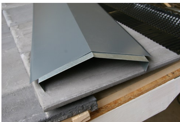
Monteringsbild 3. Justera nockbyglarna så de stämmer med nockplätens böckning.
