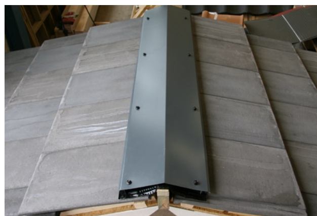
Monteringsbild 6. Skruva nockplåten ca 20 mm från bygelns nedre kant på båda sidor. Använd plåtskruv med bricka av typ farmarskruv, kan fås i samma färg som plåten.
