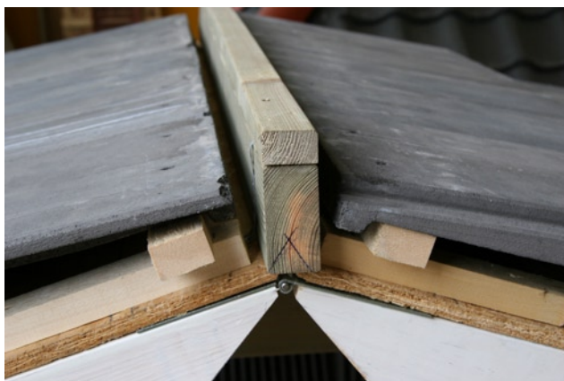
Monteringsbild 1. Anpassa nockbrädans höjd i förhållande till taklutningen (se tabell sid 1).
